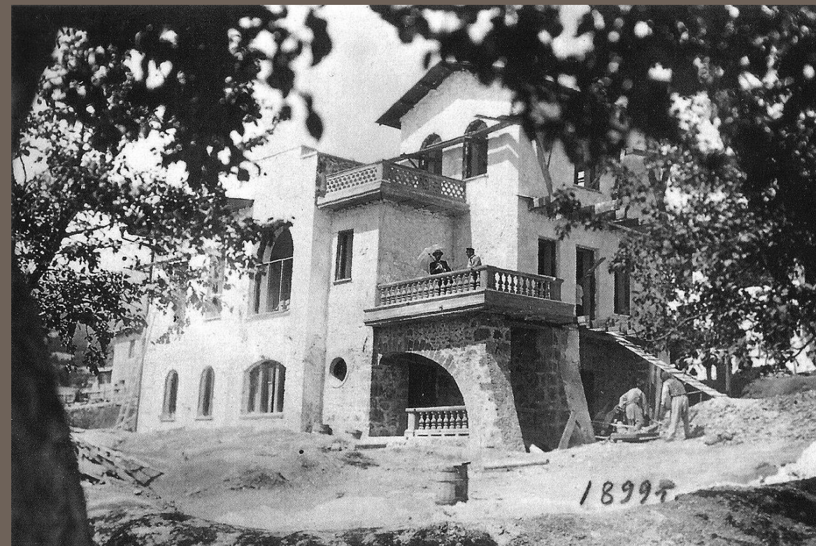
Строящийся дом А.П. Чехова в Ялте. 1899 г.
