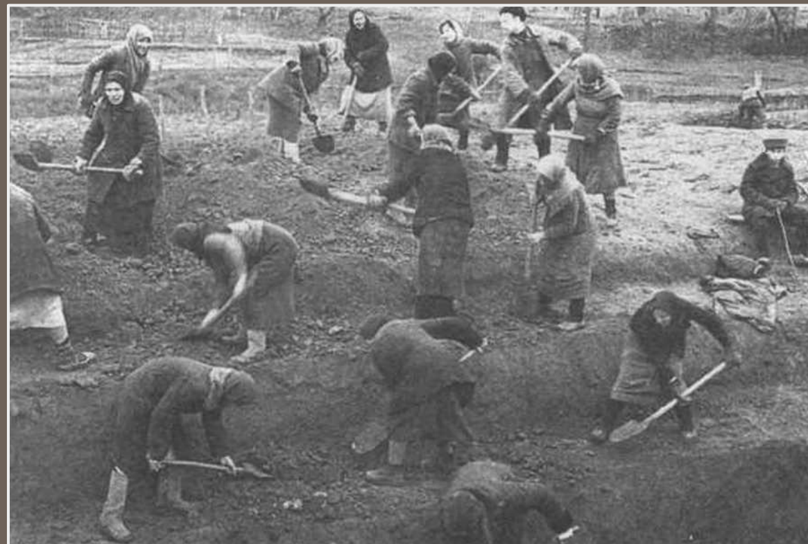
Строительство оборонительного рубежа
