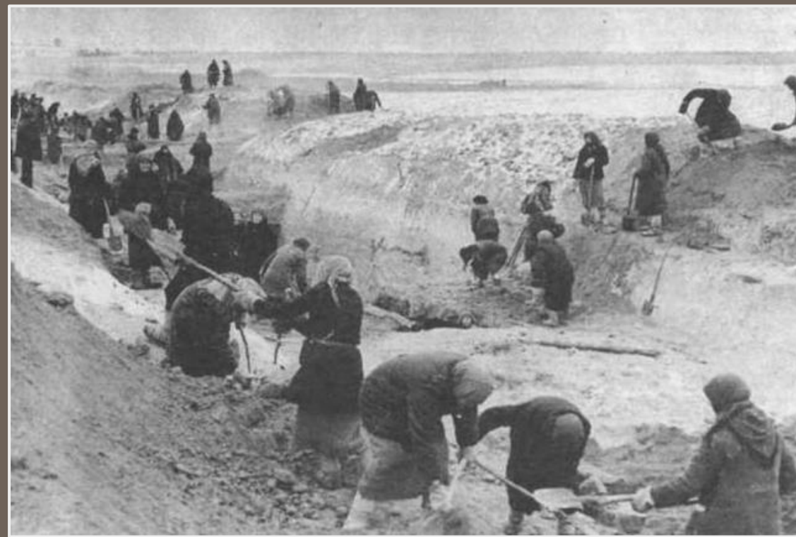
Строительство оборонительного рубежа
