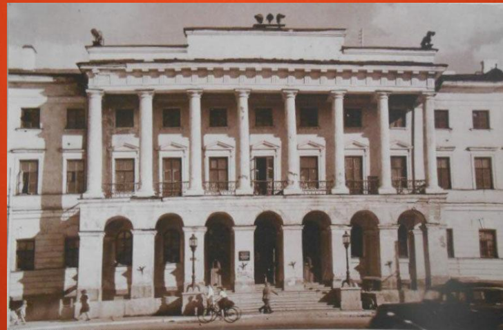
Здание сельскохозяйственного института (1940-е годы)
